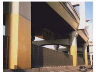
高速道路の柱脚の補強
