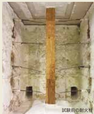
試験前の耐火柱
