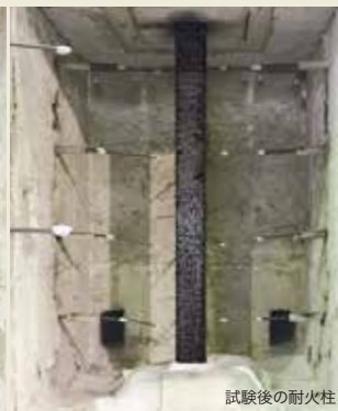
試験後の耐火柱
