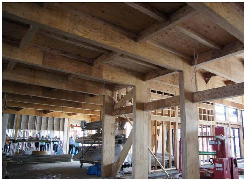
LVL 厚板壁を用いた建築物
