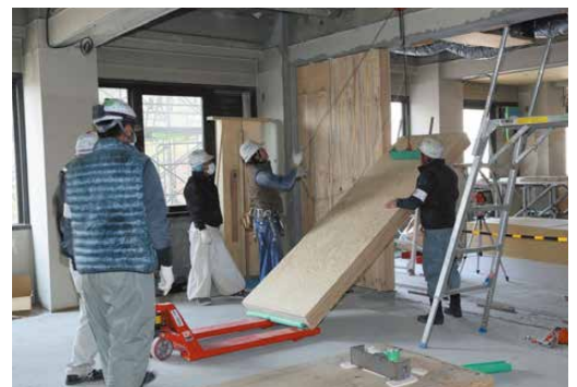
38mm厚LVLパネルを4枚重ね合わせ建込む
