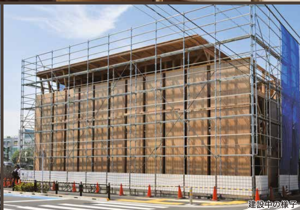
建設中の様子
