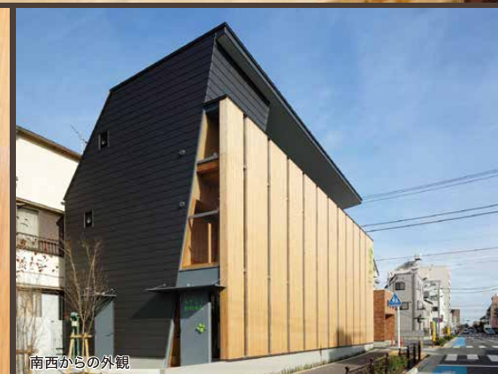
南西からの外観
