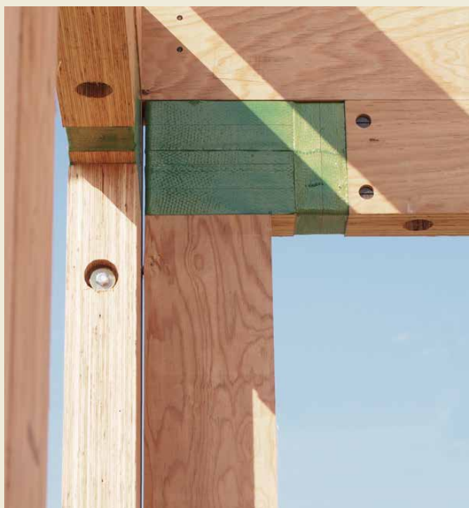
写真上・左下・右下: キーラム 耐震開口フレーム 施工事例
