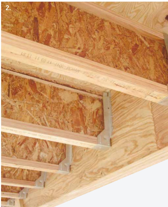
1.在来軸組構法住宅 / 2.キールム ジョイスト 施工事例
