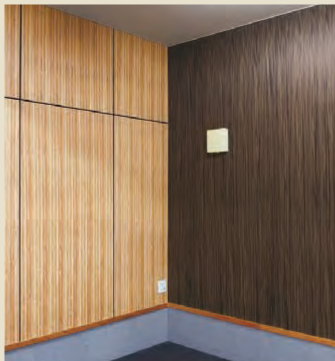
写真上・左下:金石市民ホール TETTO 天井:バームクーヘン スギLVL積層面(設計/aat+ヨコミゾマコト建築設計事務所) 写真右下:キーテック木更津工場 事務所 施工事例 左壁面:バームクーヘン化粧パネル スギLVL積層面、右壁面:バームクーヘン エボニー
