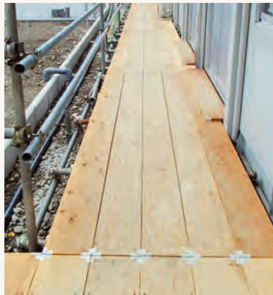
国産材足場板 使用事例
