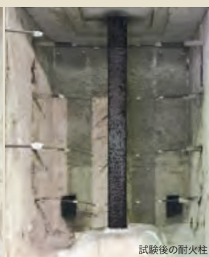
試験後の耐火柱
