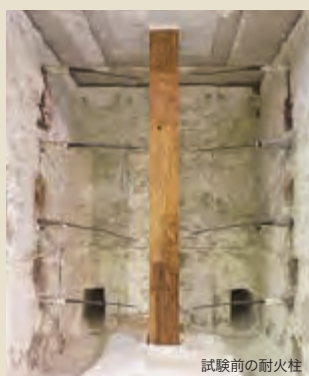
試験前の耐火柱
