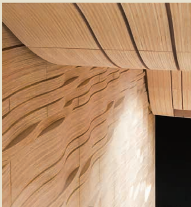
写真上・左下:金石市民ホール TETTO 天井:バームクーヘン スギLVL積層面(設計/aat+ヨコミゾマコト建築設計事務所) 写真右下:キーテック木更津工場 事務所 施工事例 左壁面:バームクーヘン化粧パネル スギLVL積層面、右壁面:バームクーヘン エボニー
