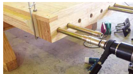
ラグスクリューボルト打ち込み
