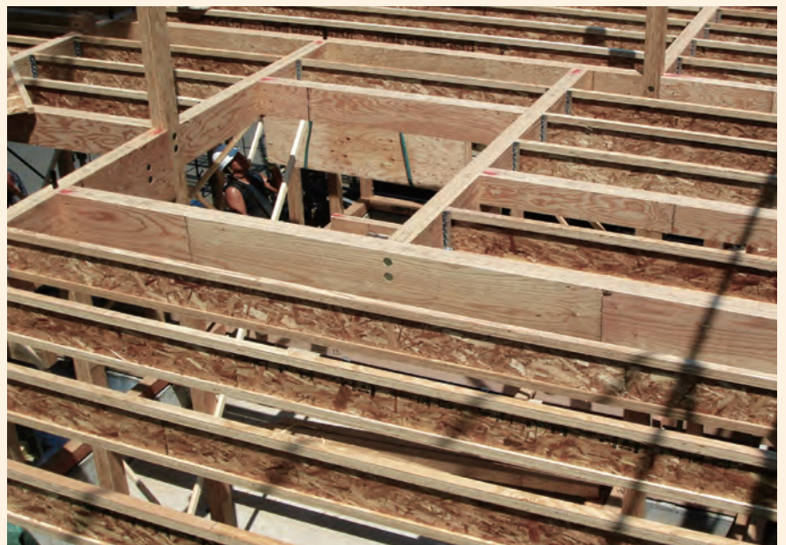
在来軸組構法住宅におけるキーラムジョイストの施工
